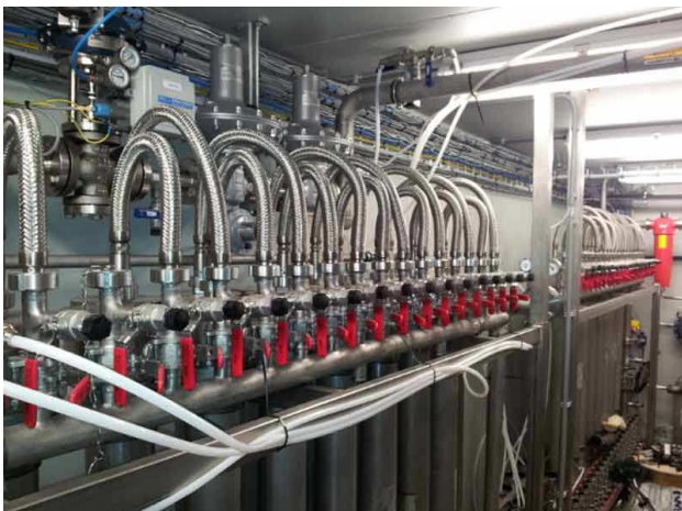
Combinaison de modules membranaires Source : DMT (membranes Evonik)
