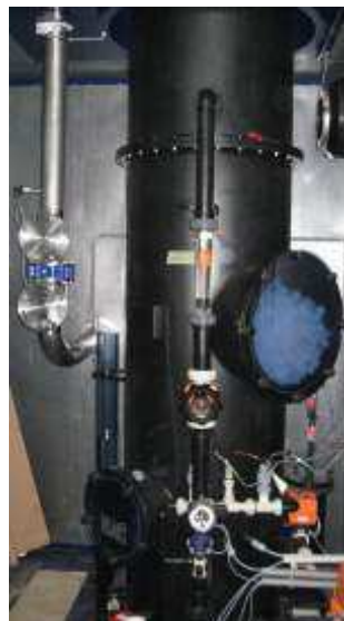
Colonne de lavage basique Source : BiogasBruckGmbH
