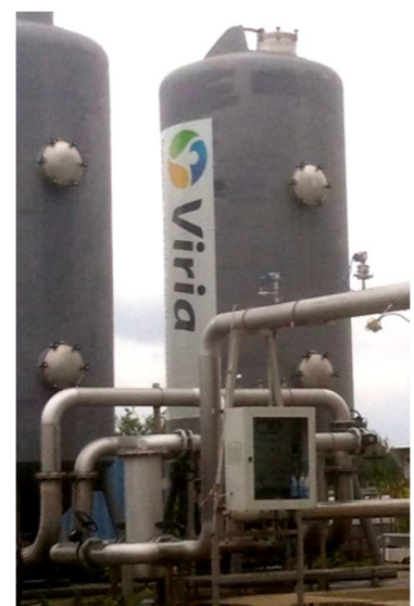
Cuve de filtration charbon actif Source : VerdeMobil
