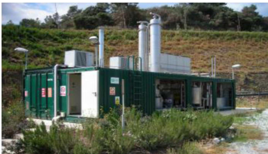
Unité d'épuration aux amines à Vacarisse (Espagne) Source : HeraCleantech
